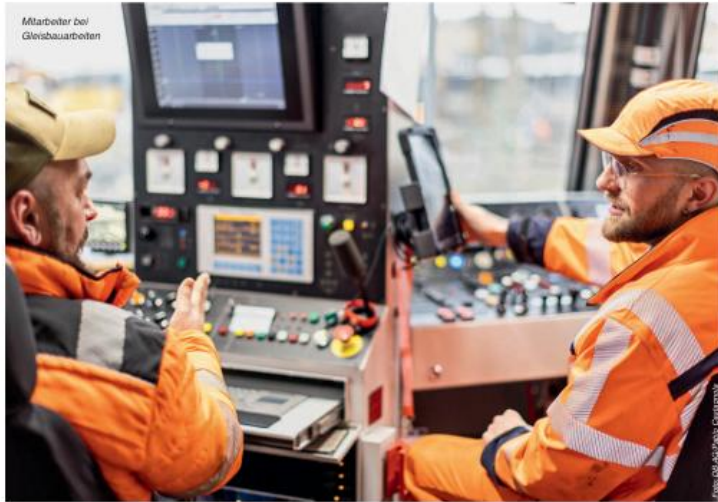
Mitarbeiter bei Gleisbauarbeiten
